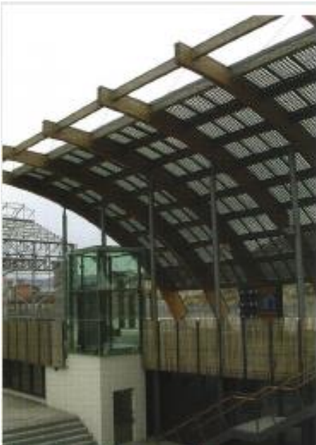
Torem fotovoltaico all'ecoparco di Torino
