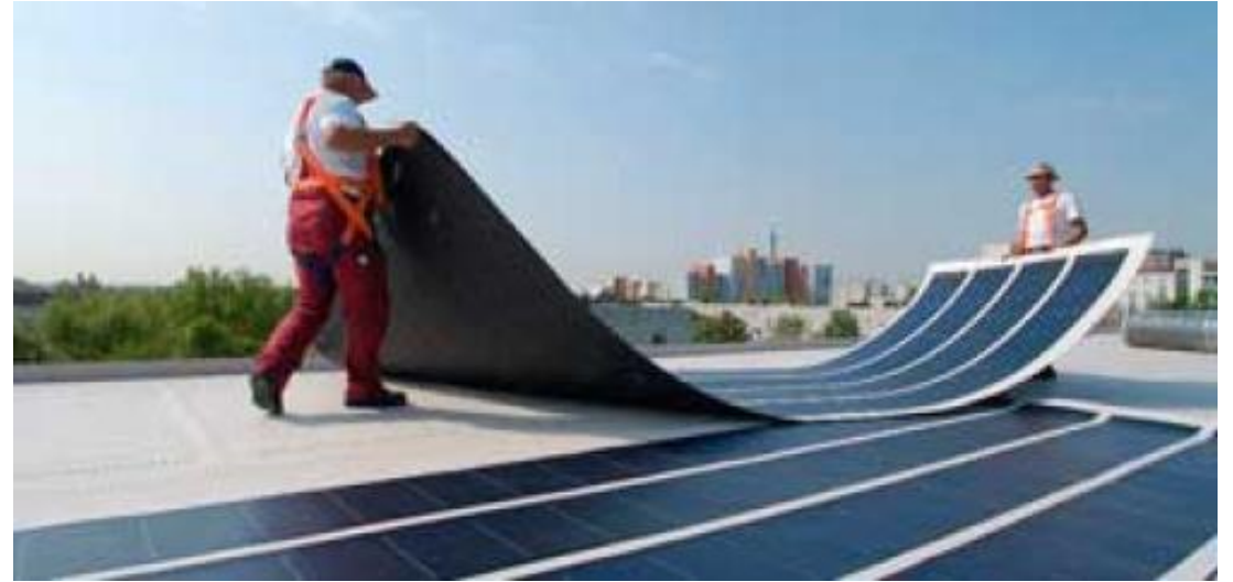
Un momento della posa in opera su superfici piane
