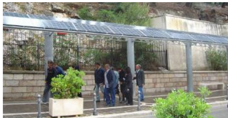
San Giovanni Rotondo Pensilina fotovoltaica su percorso pedonale
