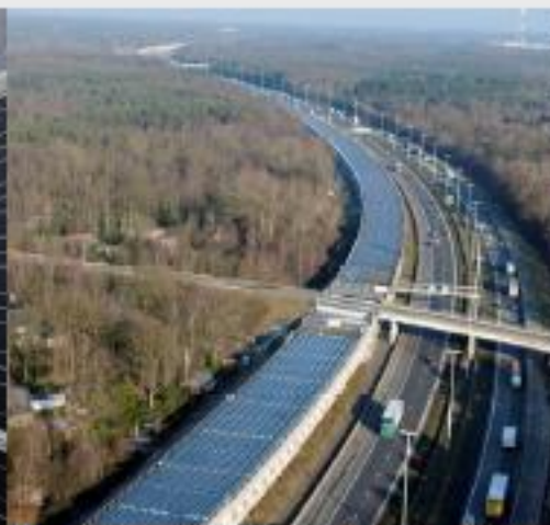
Tunnel ferroviario fotovoltaico lungo 3,6 km in Belgio. 16.000 pannelli solari. Producibilità pari a 3.300 MWh.
