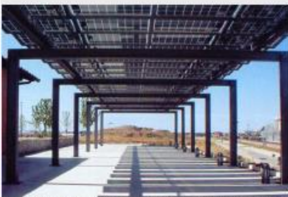
Pensilina costituita da moduli fotovoltaici e dai relativi sistemi di supporto. Centro Direzionale del Polo Tecnologico Industriale Tiburtino 2004, Roma, Italia. Studi architetti Abbate e Vigevano _ AeV Architetti
