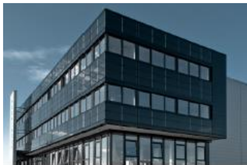
Hechingen , VS-Schwenningen, 164 kWp
