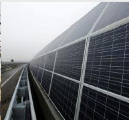
Moduli fotovoltaici utilizzati come barriere antirumore lungo arterie stradali a scorrimento veloce e lungo la ferrovia. Ferrovia di Wallisellen in Svizzera.
