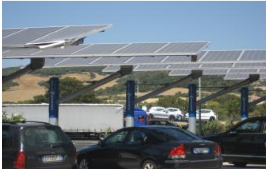
Sanyo-albero. Pensilina fotovoltaica e ricarica per auto elettriche
