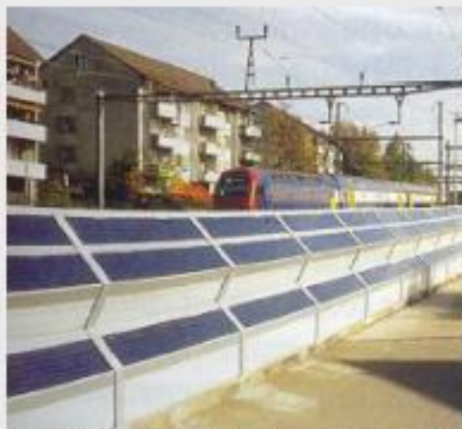
Moduli fotovoltaici utilizzati come barriere antirumore lungo arterie stradali a scorrimento veloce e lungo la ferrovia. Ferrovia di Wallisellen in Svizzera.
