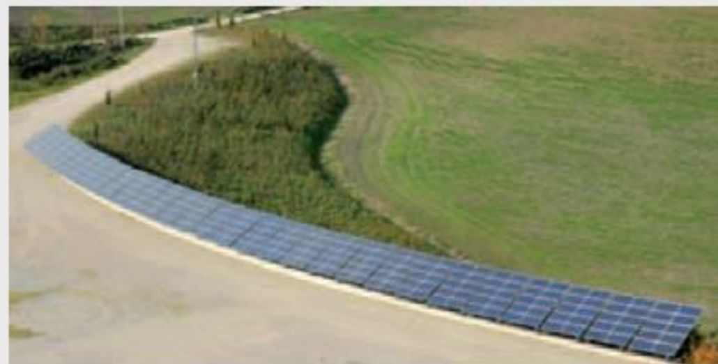
Barriere acustiche e fotovoltaiche e le infrastrutture
